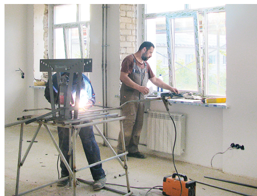
Ремонт идет полным ходом
