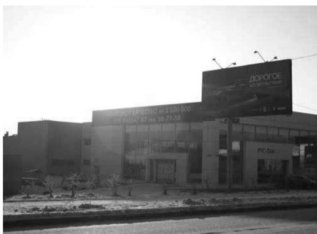
РК 5 Сторона Б ул. Дорожная, 130,5 м. от пересечения с ул. Калинина, слева при движении к ТРК «Вернисаж»
