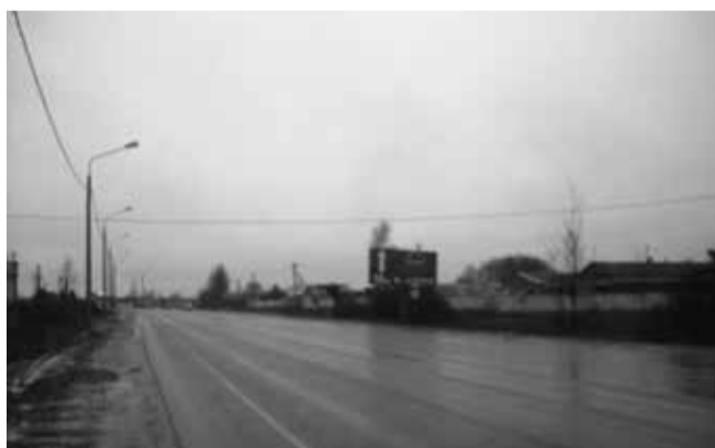
РК 134 ЮЗОД, 250м от дороги на КУРБУ, сле- ва при движении к реке КОТОРОСЛИ, 10 м. от кромки проезжей части авто- дороги (сторона А)
