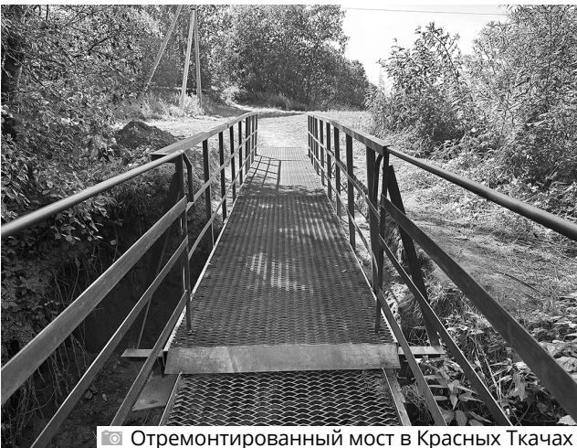
Отремонтированный мост в Красных Ткачах
